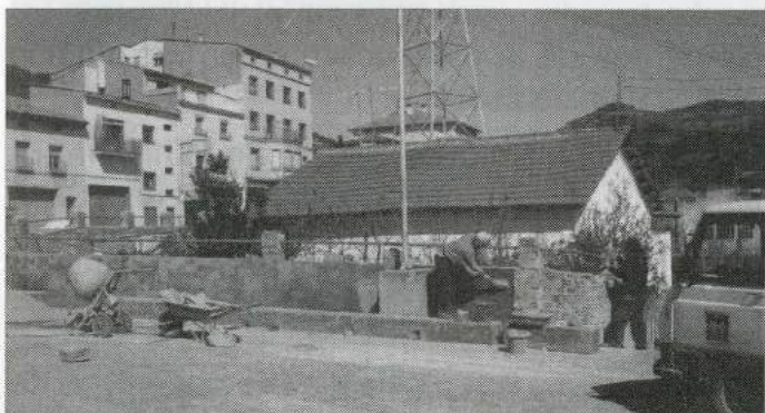
La Poble millora la seva imatge, restaurant la tanca de l'estació.
